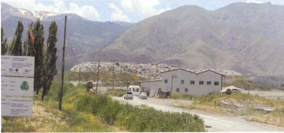
Fotoğraf 5. Depolama alanından bir görünüm.
