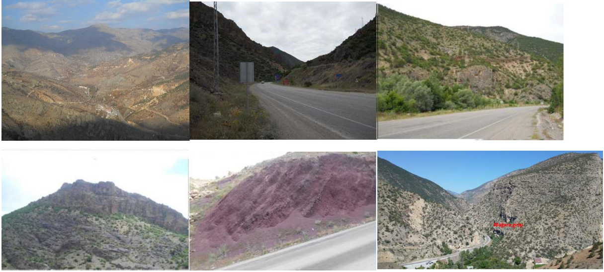
Şekil 2. Litolojik birimlerin karakteristik görünüm ve lokasyonları ve yol kenarındaki kapalı karstik mağara.
