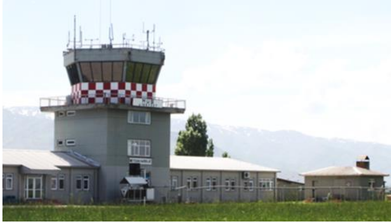
Fotoğraf 8. Muş Havalimanı hava trafik kontrol kulesi
