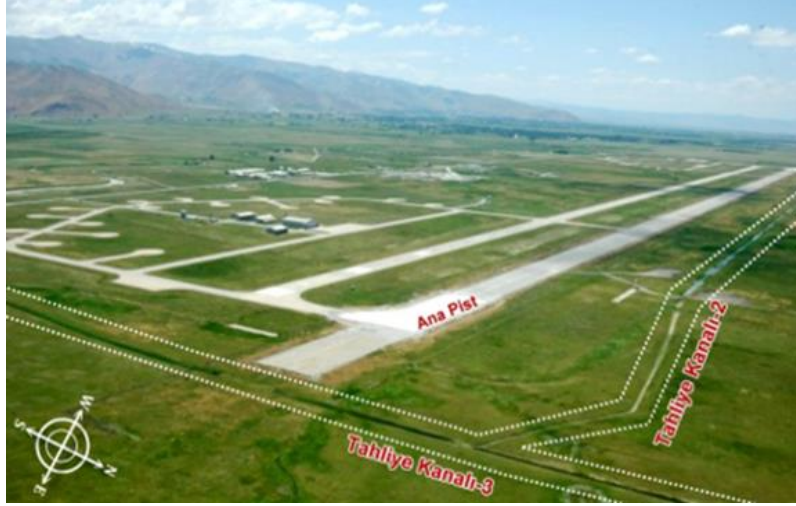
Fotoğraf 14. Havalimanının kuzey ve batısındaki akarsu tahliye kanalları.
