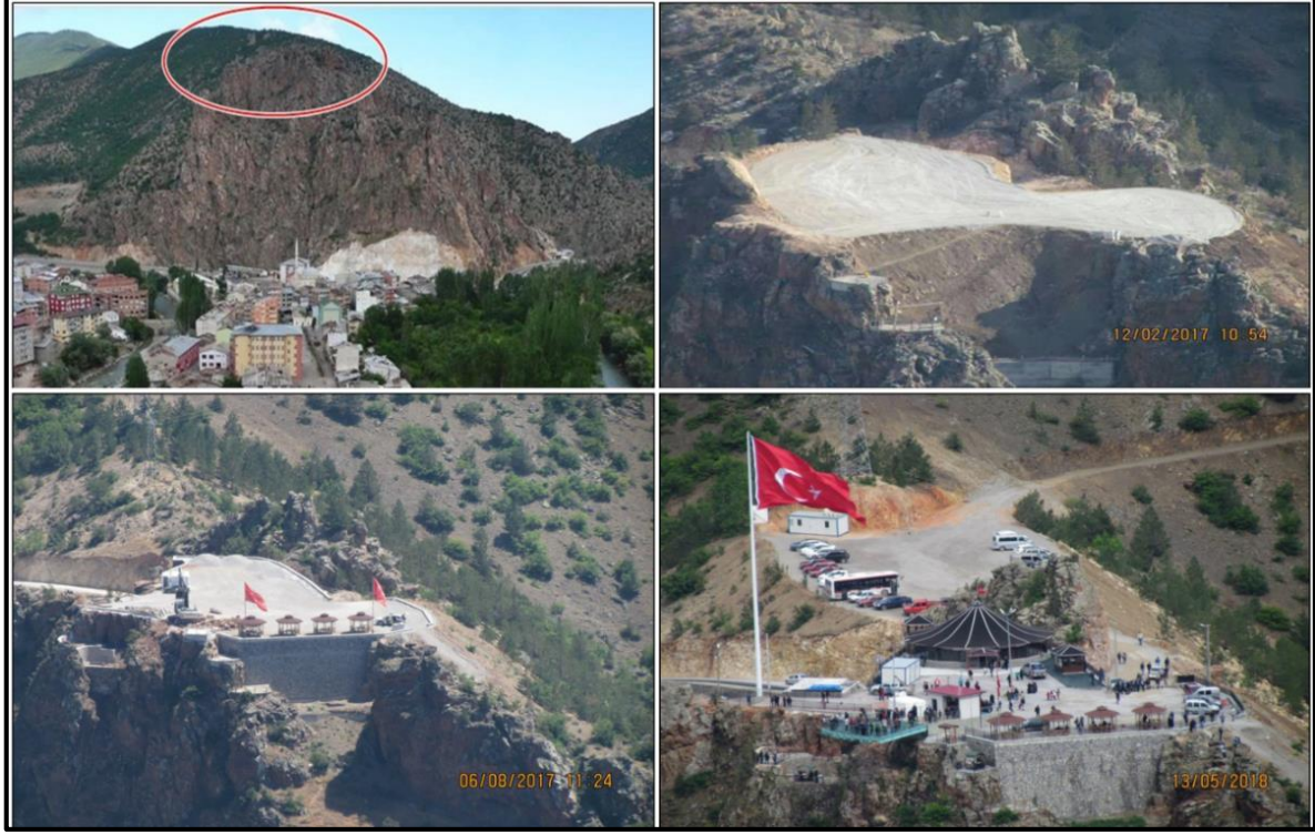
Şekil 6. Tesisin Yapılış Aşamalarını Gösteren Fotoğraflar (Kaynak: Torul Belediyesi, 2018).
