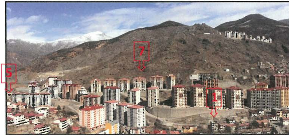
Foto 1. Oltanbey mahallesindeki kaya düşmelerinin yaşandığı yerler.
